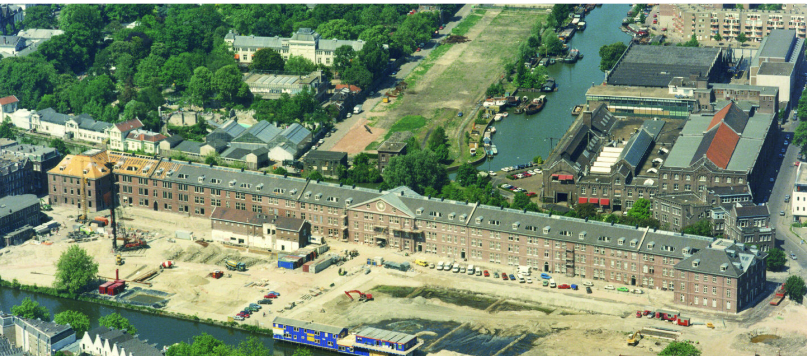
Kazerne tijdens renovatie
