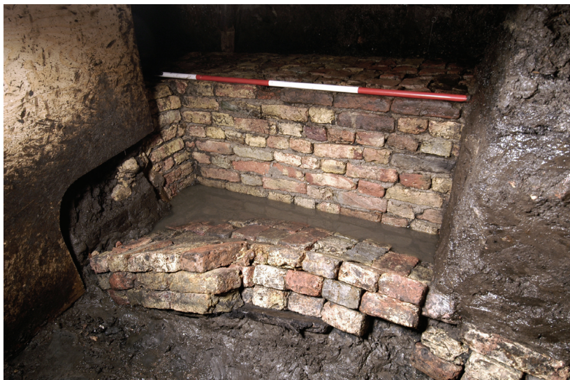
6 Binnenzijde van de oostmuur gezien richting oosten. Links is de eerste (noordelijke) muurdam te zien, op de voorgrond het bakstenen plateau tussen de muurdammen
