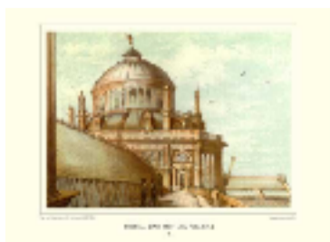
Koepel. (Van het dak gezien.)
