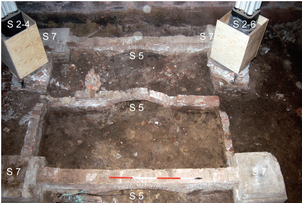
6 Fundering van het kerkgebouw uit de eerste fase van 1710, gezien richting noordwesten, bestaande uit het muurwerk met spaarbogen (S 5) en de vier basementen (S 7). De pilaren van de huidige kerk staan op basementen (S2-4 en S 2-6) die stammen uit de tweede fase na 1848
