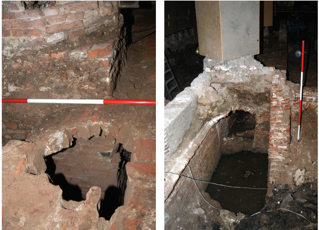
9 Fasering riool tussen tweede en derde fase. Links: het gewelf van het 18de-eeuwse riool (S1) is om het reeds aanwezige basement van pilaar S2-5 uit de tweede fase (1848) aangelegd. Rechts: de (tijdelijk ingepakte) pilaar S3-7 uit de derde fase (1899) is op het dan reeds aanwezige riool geplaatst
